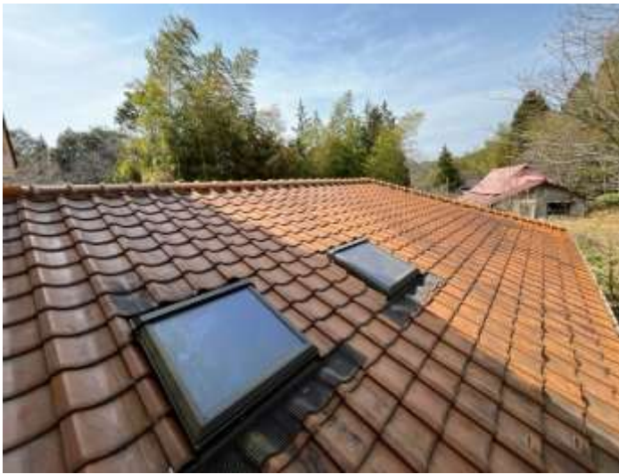
㊺完工後の仕上がり状況
