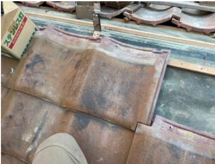
⑫瓦の葺き戻し作業(陸棟)
