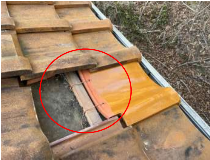
⑯破損軒瓦の交換
