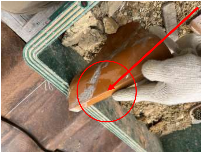
⑨瓦の葺き戻し作業(隅棟)
