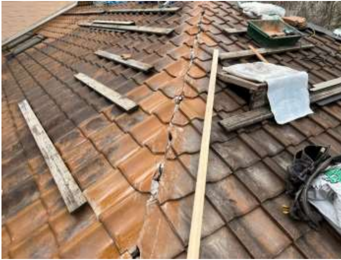
⑪瓦の葺き戻し作業(陸棟)
