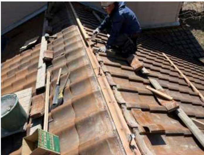
⑫瓦の葺き戻し作業(陸棟)
