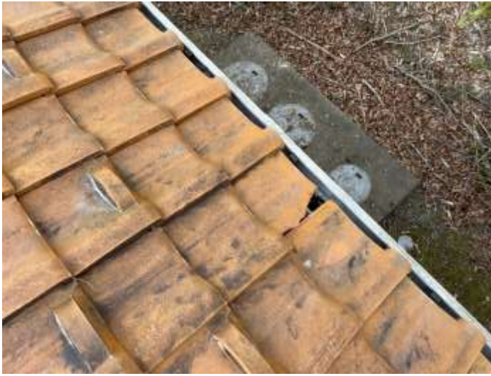
⑮破損軒瓦の交換
