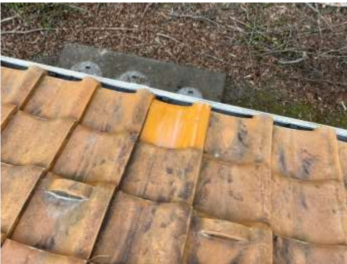
⑯破損軒瓦の交換
