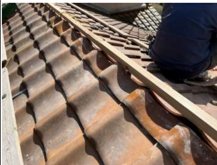
⑭棟心材の取り付け(隅棟)
