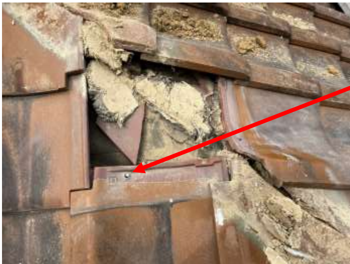
⑨瓦の葺き戻し作業(隅棟)
