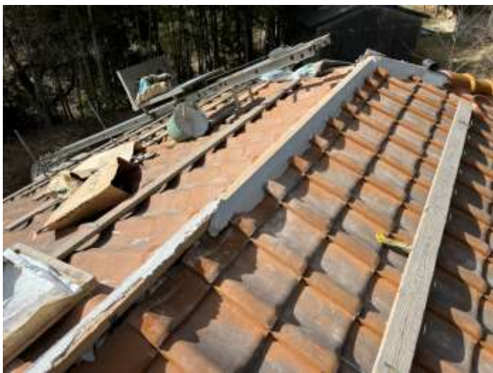
⑪棟瓦の取り付け
